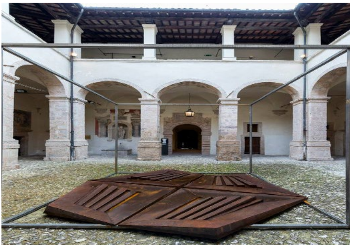
Chiostro (prima della realizzazione della sala conferenze)
